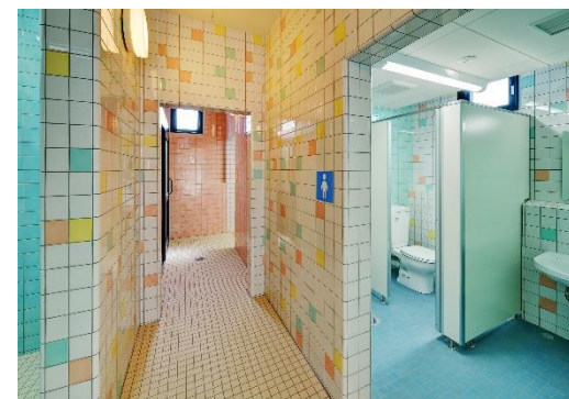
プールサイドトイレ外観
